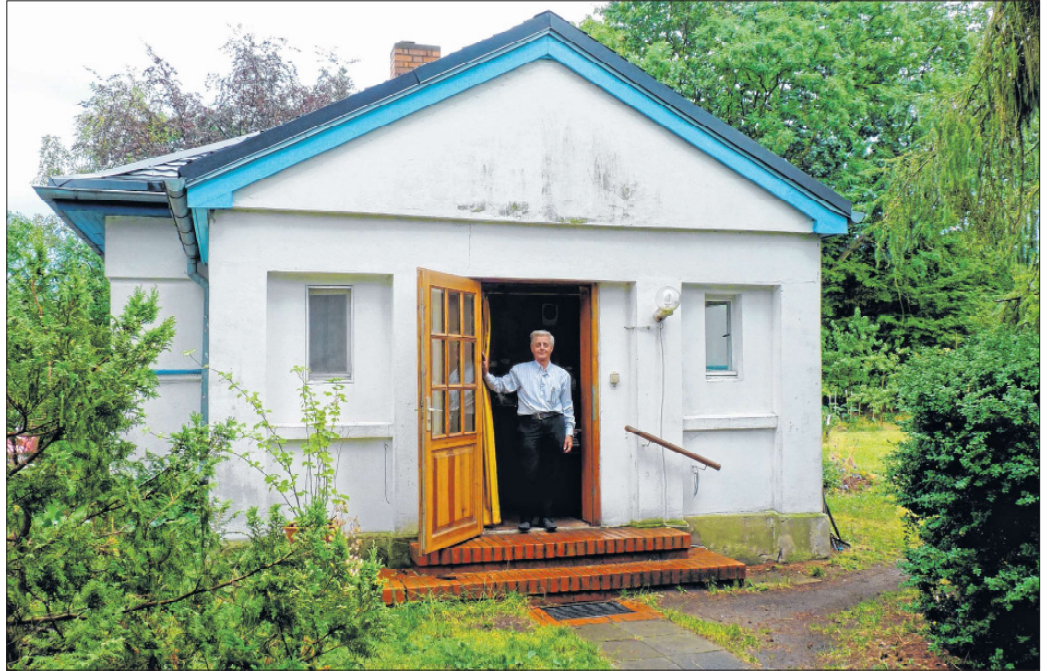
Schlichter Massivbau: Das Haus ist seit dem Tod von Anna Rubner außen und innen fast unverändert geblieben. Seit 2012 steht es unter Denkmalschutz. Foto s (2): Marion Voigt
